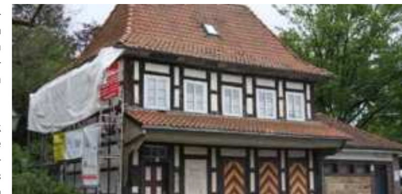
Die derzeitige Frontansicht der ehemaligen Obertorwache in der Kasseler Straße. In den kommenden Wochen wird auch die Vorderseite des Gebäudes saniert. M. Simon / Pressestelle Stadt Hann. Münden
