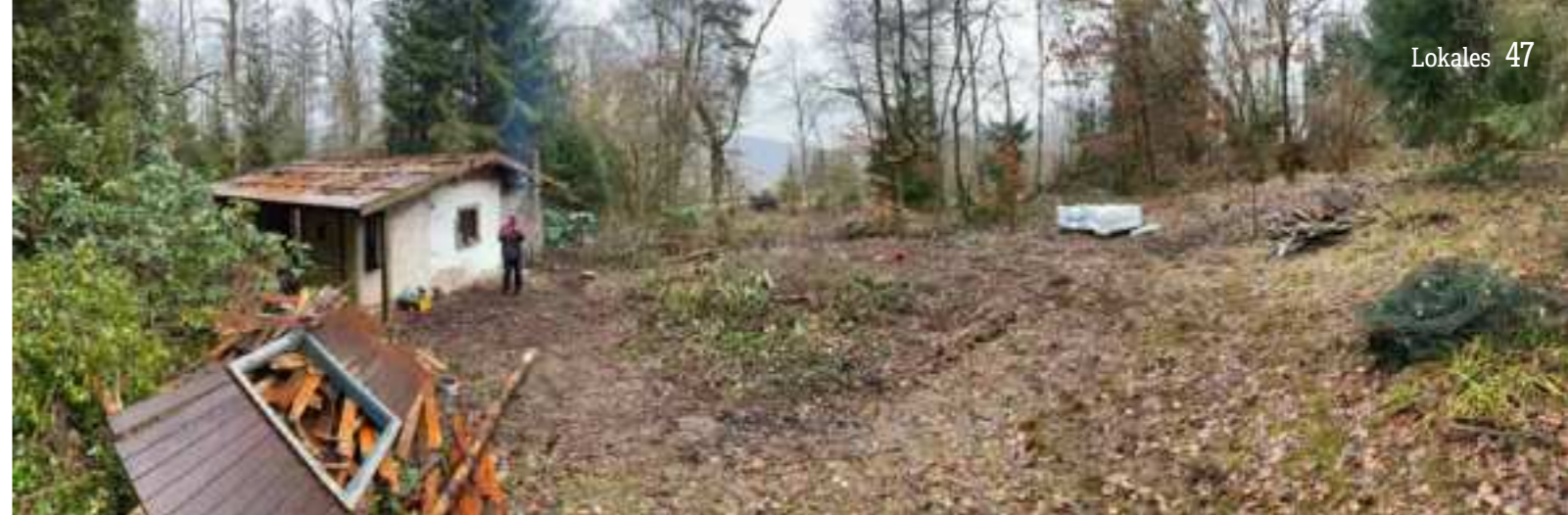
Hier entsteht eine neue Waldkita in Bonaforth.
