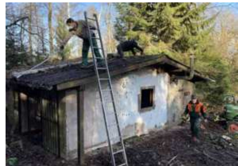
Aufräumarbeiten als Grundlage für die neue Kita.
